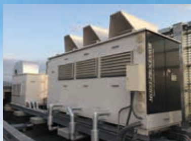
モイストプロセッサ設置風景
